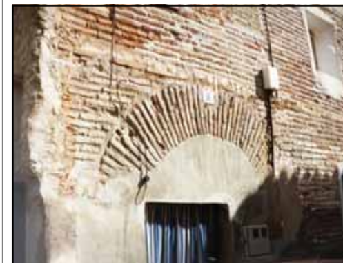
Detalle de fachada en la calle Falcón
